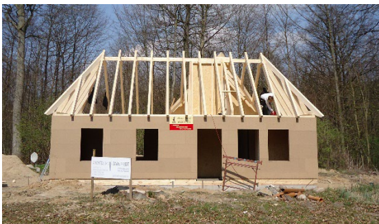
Ansicht des Rohbaus
