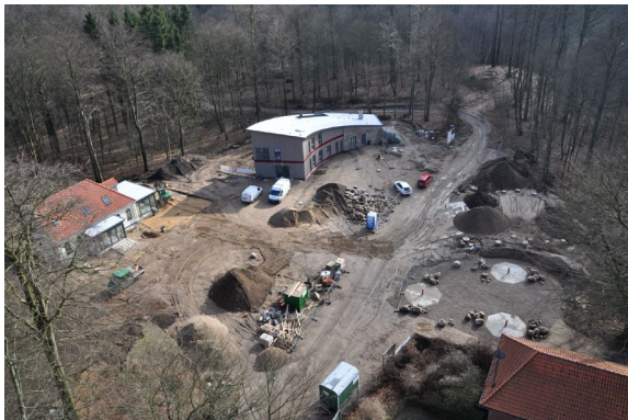
Blick auf die Baustelle vom Fernsehturm aus
